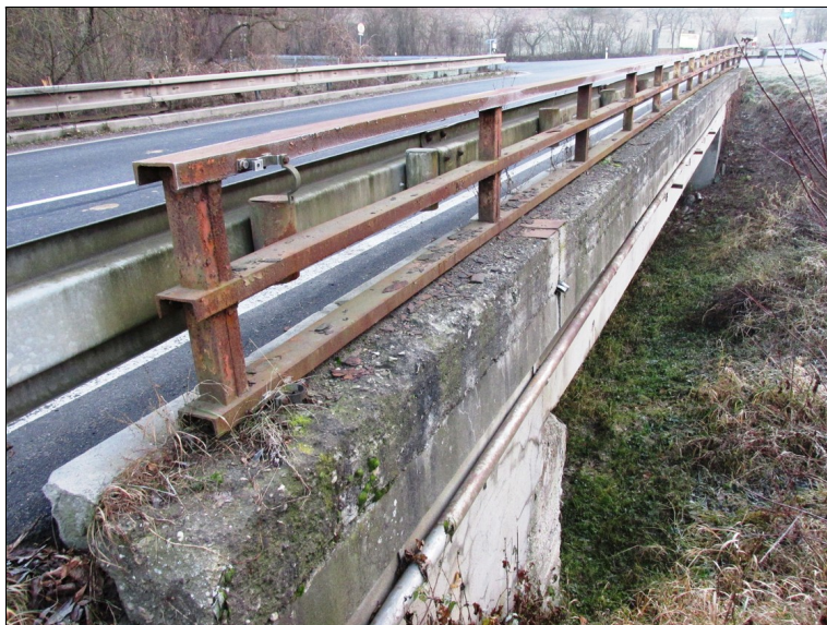
Rozpad povrchu betonu říms, koroze povrchu zábradelního svodidla - zde pravá starna.
