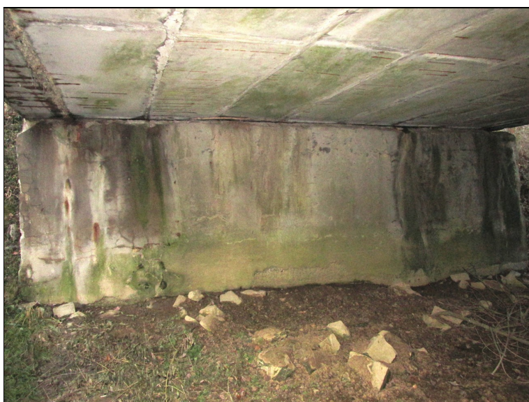
Pohled na opěru OP1 - silné průsaky, degradace betonu při patě OP; rozplavené opevnění.
