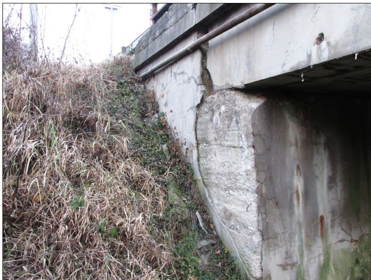
Opadávající omítka opěr, zvodnělá spára mezi NK a závěrnou zídrou - zde pravé křídlo OP1.
