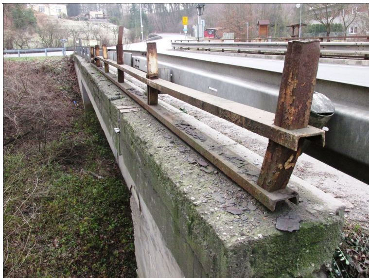
Rozpad povrchu betonu levé římsy, zkorodované zábradelní svodidlo, chybí madlo.
