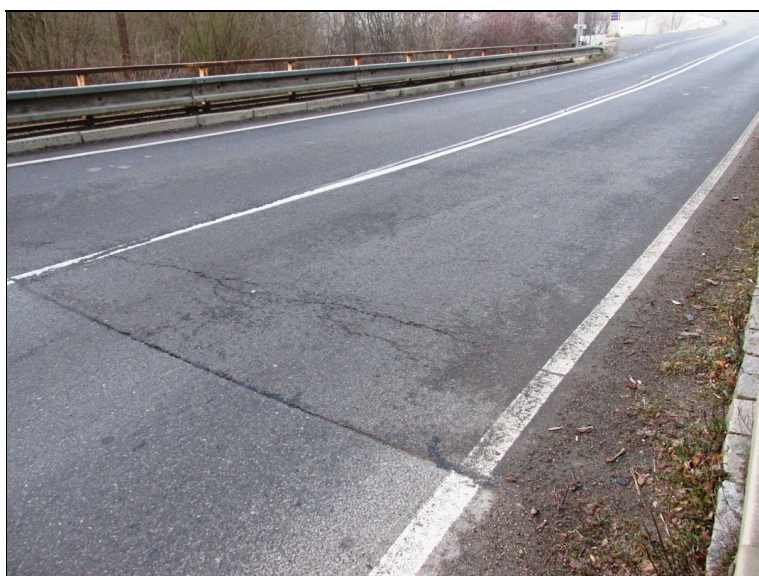
Příčné trhliny ve vozovce za opěrou OP2 vlevo, nečistoty na krajnici.
